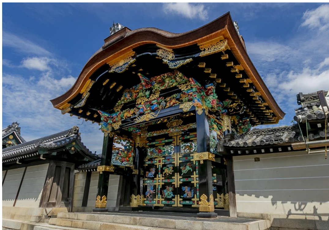
西本願寺 唐門(2021年9月30日修復完了)
