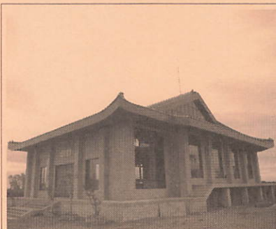
法雷寺、建設中の本堂
